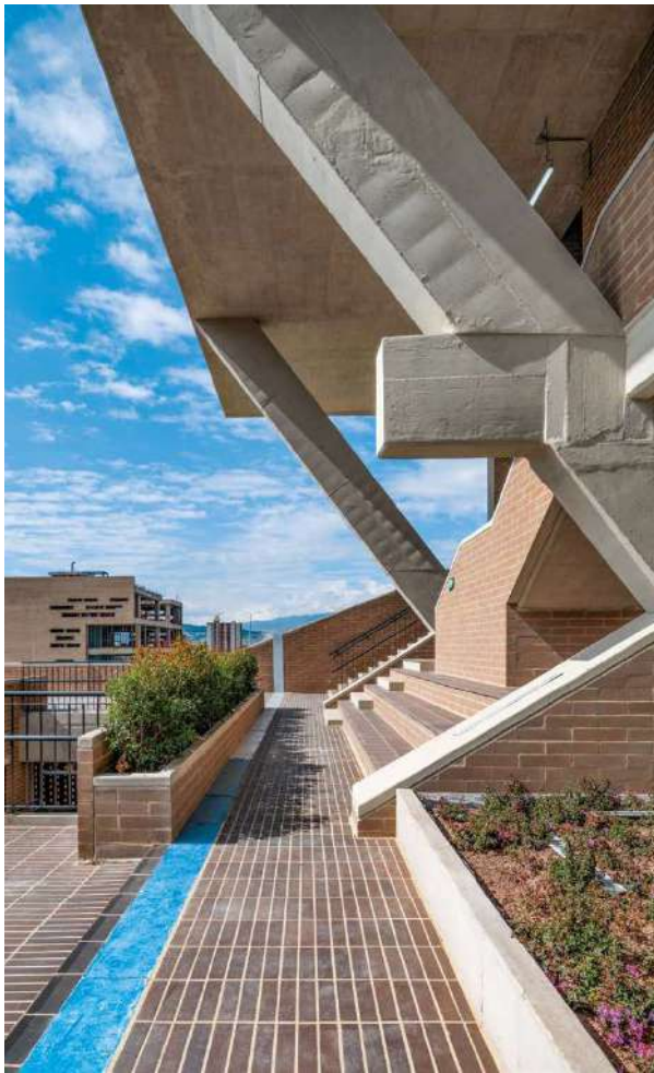
Las atipicidades del sistema estructural del proyecto se revelan para ser parte de su expresión formal y material.
